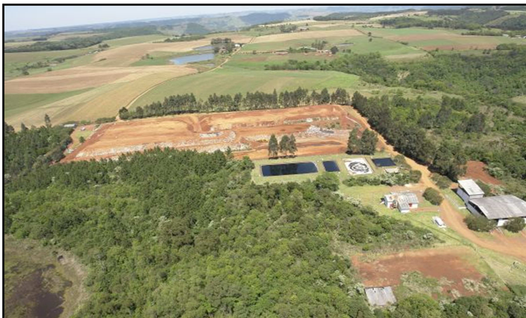
Figura 22: Aterro Sanitário da empresa TUCANO em Saudades – SC
