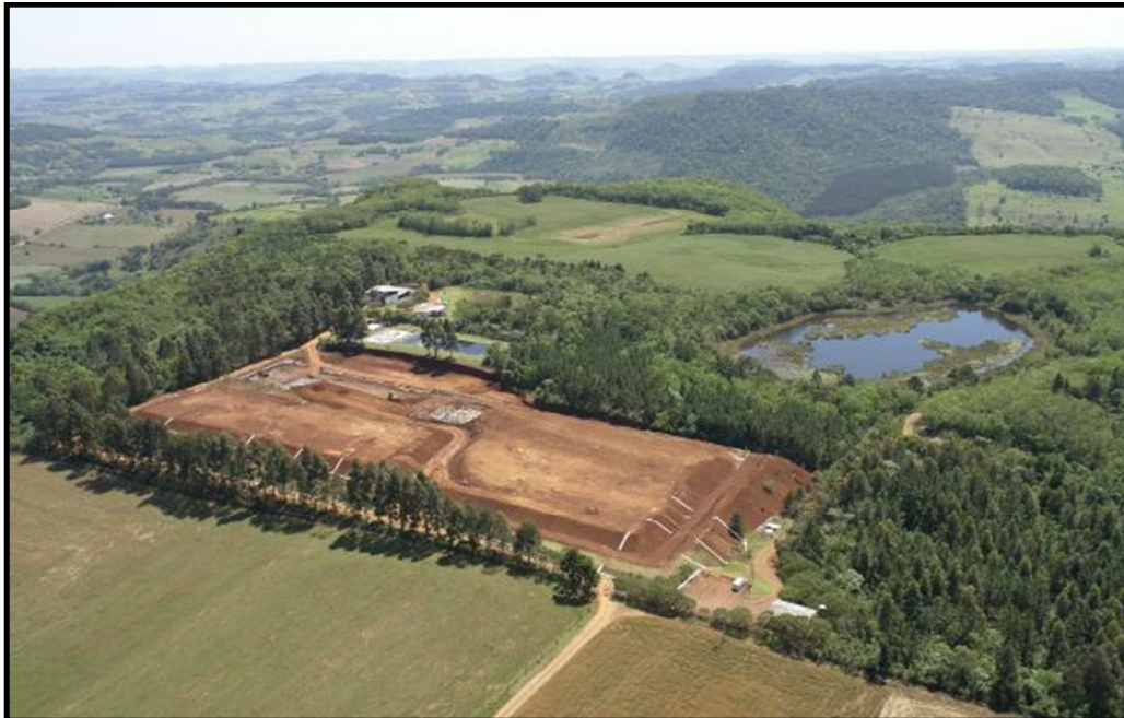
Figura 20: Aterro Sanitário da empresa TUCANO em Saudades – SC
