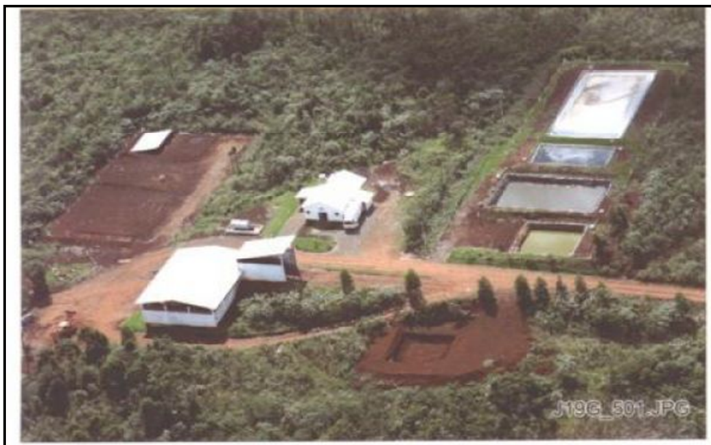
Figura 21: Aterro Sanitário da empresa TUCANO em Saudades – SC
