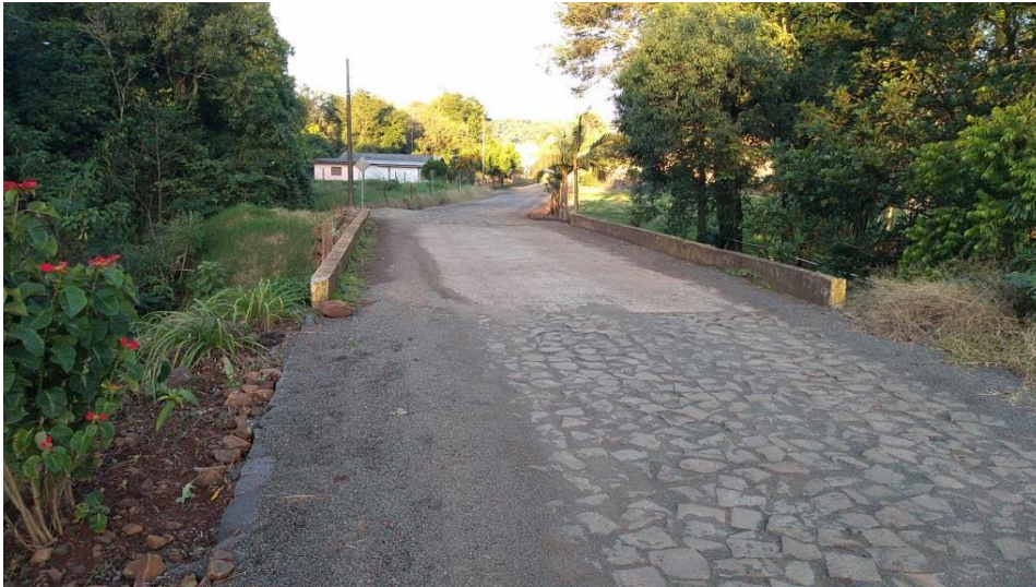
Imagem 03: Travessia do Rio Pinheiro pela ponte em concreto.
